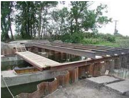
Diese Baustelle zwischen Pessin und Senzke macht eine Umleitung erforderlich
